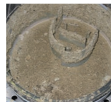
Abscheidebehälter, voller Schlamm
