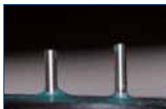
De schoon afgewerkte plaatsen waar de stiften door de folie steken.
